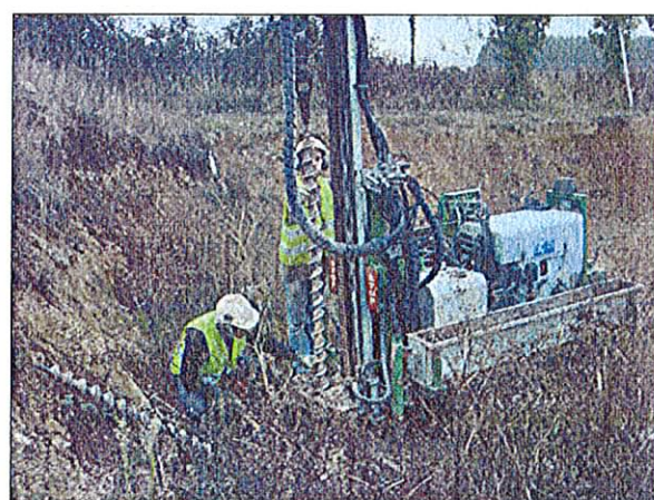
Sondage C4 en partie centrale du site
