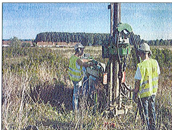
Sondage C5 en partie centrale du site
