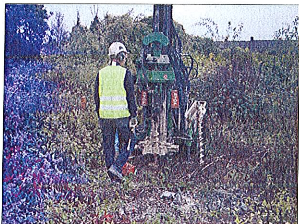
Sondage C1 à proximité du piézomètre Pz3
