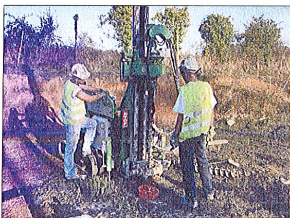
Sondage C3 en partie centrale du site
